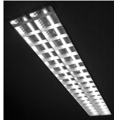
Die besonders auf Qualität und Lichtausbeute optimierten LED-Tubes der PROFILED bieten einen meist gleichwertigen Ersatz von konventionellen Leuchtstoffröhren bei einer Halbierung der Leistungsaufnahme\*. In Leuchten mit KVG bzw. VVG können die LED-Tubes kinderleicht mit Austausch des mitgelieferten LED-Starters eingesetzt werden. Leuchten mit EVG müssen umverdrahtet werden - eine Anleitung hierfür liefern wir Ihnen gerne mit.
